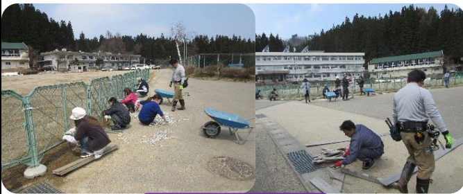
雪囲い撤去作業
