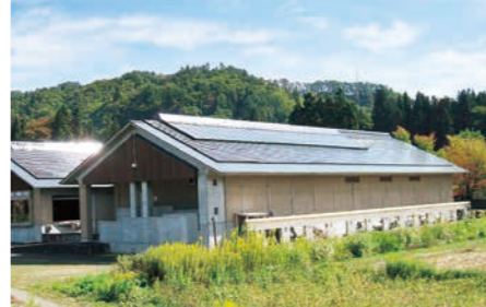
斎藤清美術館に太陽光発電設備設置(平成25年)
