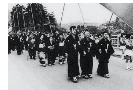
瑞光寺橋が完成し、渡り初めが行われる(昭和47年)
